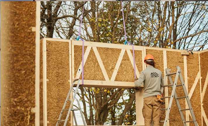
Prefab houtskelet met stro als isolatie © EcoCocon
