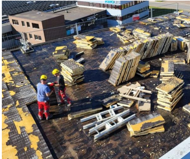
1 plat dak (PUR)
